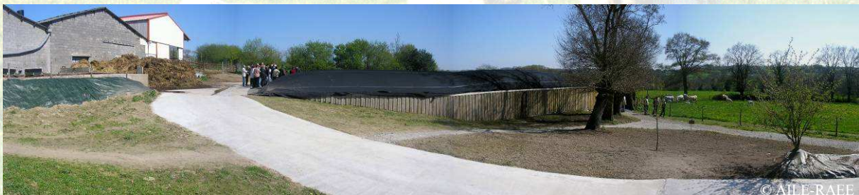
Vue sur l'unité de méthanisation et une partie des bâtiments d'élevage
