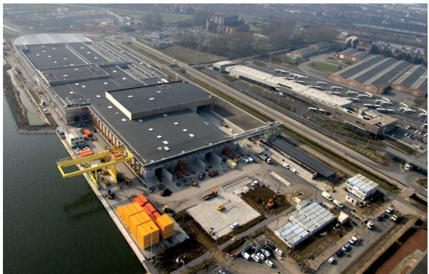
Centre de traitement de Lille Métropole et stations d'avitaillement des bus.
