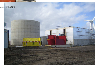
Installation de Zeewolde (Pays-Bas) (source TRAME)
